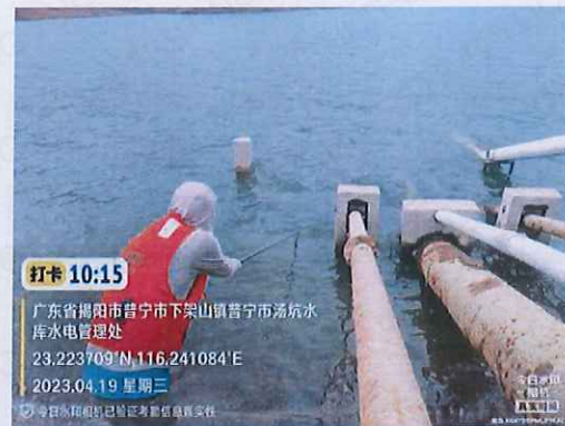
汤坑水库取水口
